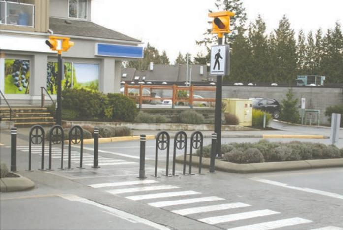
Figure 4.7 : Passage en deux segments décalés (modèle danois), photographie de David Coburn et Neil Arason
