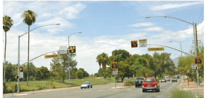
*Figure 4.13 : Passage piétonniers à feux à haute intensité activés par les piétons (système HAWK), source : [www.pedbikeimages.org](http://www.pedbikeimages.org), photographie de Sree Gajula*
